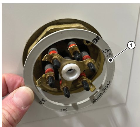
Bild 3.3 - Montering av tätningsringen
